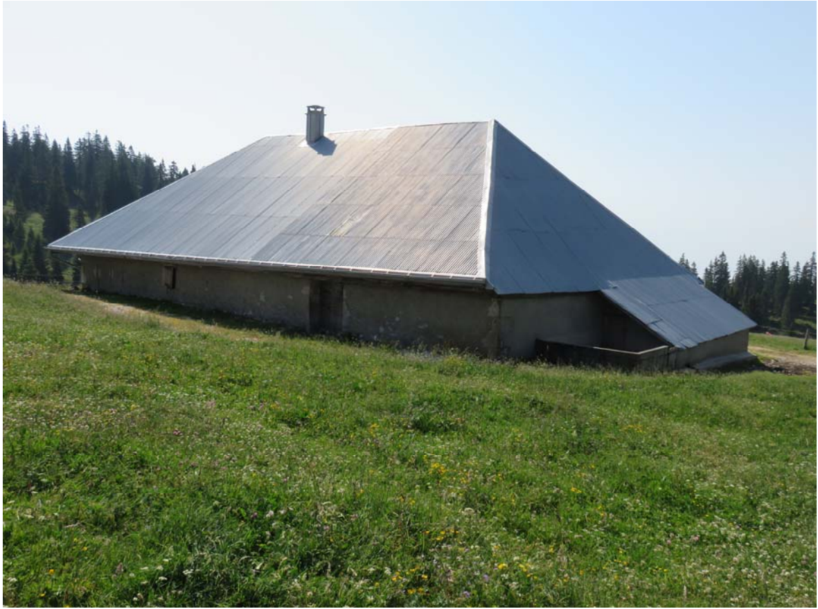
Le chalet du Petit Cunay vu de l'arrière. Son toit est impressionnant, qui se laissait déjà voir dans ses formes classiques et harmonieuses quelques jours auparavant depuis Druchaux.
